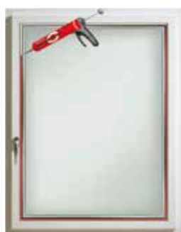
L'espace résiduel entre le verre et le cadre est traité à la colle sur toute la circonférence de la fenêtre.
